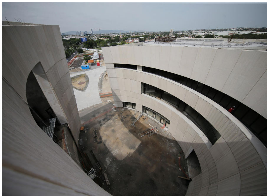
Museo de Ciencias Ambientales en construcción.
